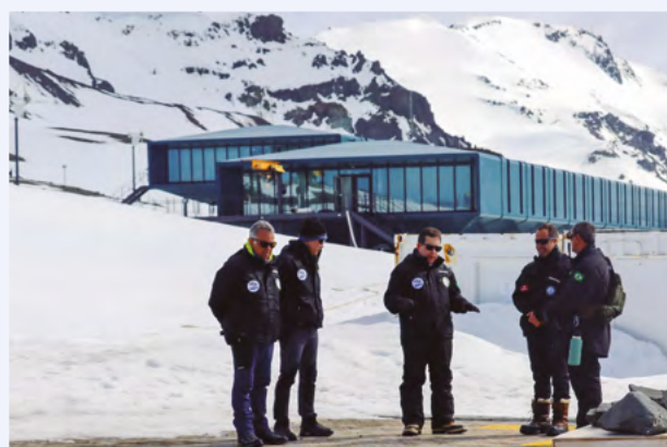
Vista Externa Setor Sul
