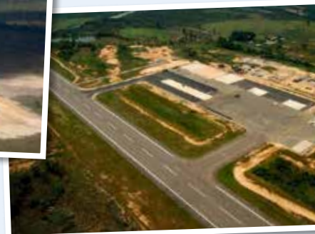
Construção da pista de Eirunepé
