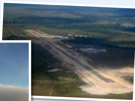
Construção da pista de Tiriós
