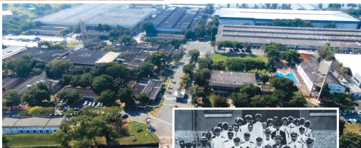
Complexo Naval de Abastecimento localizado na cidade do Rio de Janeiro
